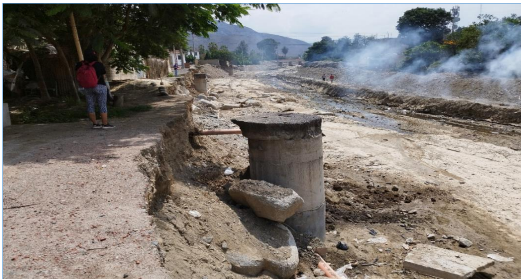
FIGURA N°03: VISTA AGUAS ARRIBA DE LA QUEBRADA MALECON SOLIVIN, EN LA IMAGEN SE PUEDE APRECIAR QUE EN LA MARGEN DERECHASE HA EROSIONADO LA VIA EXISTENTE, DEJANDO EXPUESTOS LOS BUZONES Y LA RED MATRIZ DEL SISTEMA DE ALCANTARILLADO
