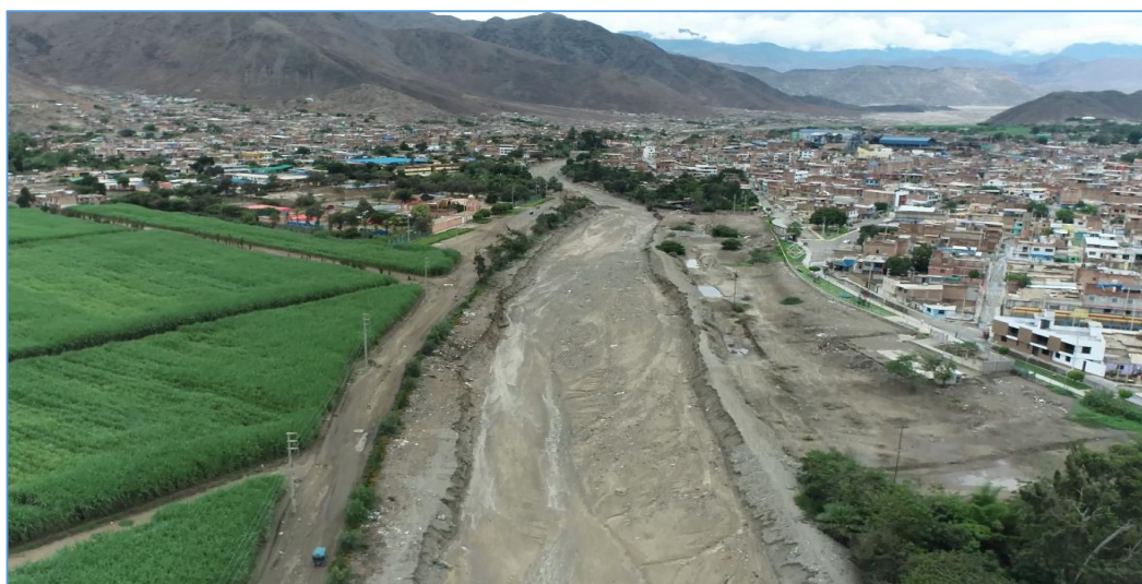
FIGURA N°01: ZONA VULNERABLE SECTOR BARRIO NUEVO, DIQUES DEBILITADOS POR LA EROSIÓN CAUSADA POR LAS AGUAS DE LA ACTIVACIÓN DE LA QUEBRADA MALECÓN SOLIVÍN
