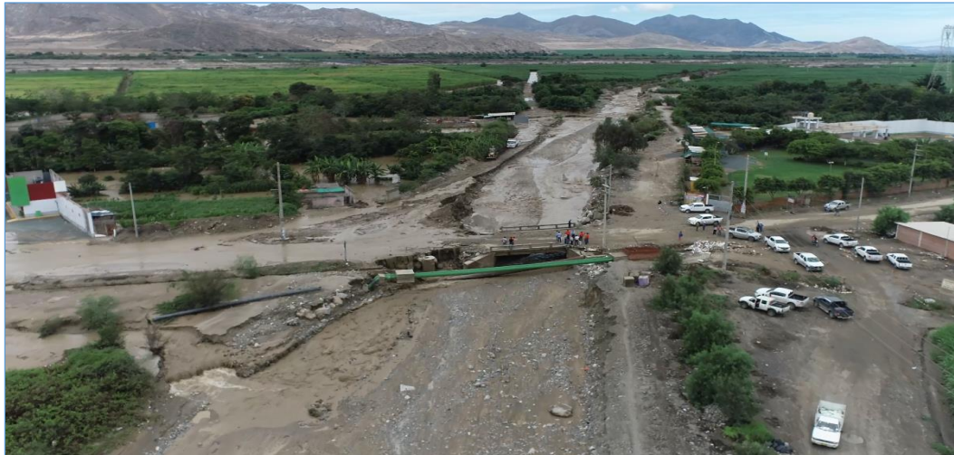
FIGURA N°02: EN LA IMAGEN SE APRECIA LA LOS DAÑOS OCACIONADOS AL PUENTE SAN JACINTO, CANALES DE REGADIO Y TERRENOS AGRICOLAS POR LA ACTIVACION DE LA QUEBRADA MALECON SOLIVIN
